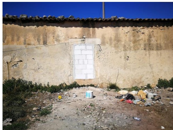
Zugemauertes Fenster der geräumten Unterkunft; Foto Borderline Sicilia
