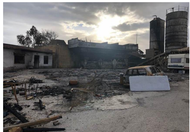
Ehemalige Zementfabrik Calcestruzzi nach dem Brand, in Campobello
