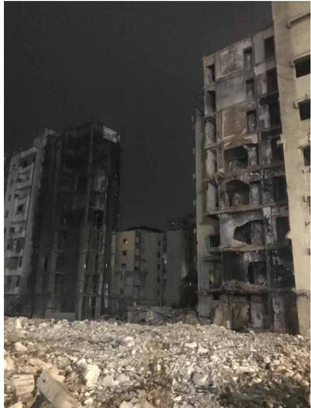
Abbildung 2: Zerstörung von Wohngebäuden in Dahieh durch das israelische Militär. Foto vom Februar 2026. Foto: Anja Pilchowski.
