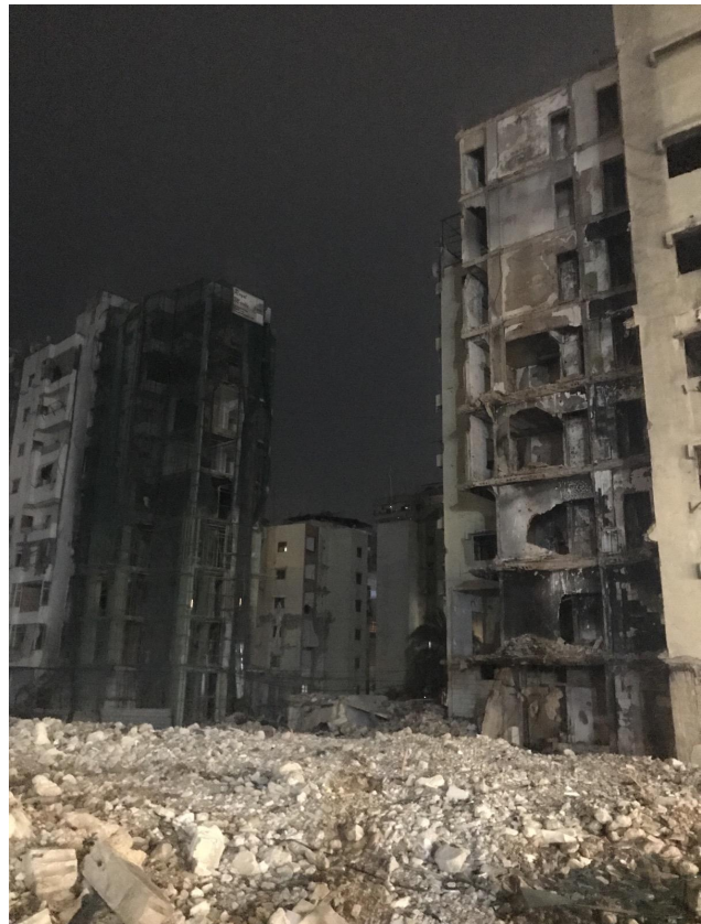
Abbildung 2: Zerstörung von Wohngebäuden in Dahieh durch das israelische Militär. Foto vom Februar 2026. Foto: Anja Pilchowski.
